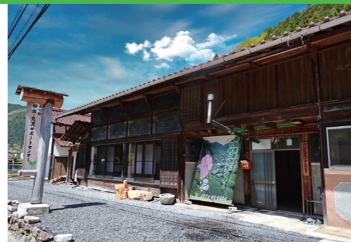
古民家を改修した白川町移住交流サポートセンター
