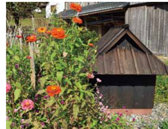
火に弱い茅葺屋根の建物を守るため、住居ごとに放水銃が設置されている（日頃は収納箱に収められている）。村内では、焚火、花火、歩きタバコが禁止であり、教科書にも明記されている
