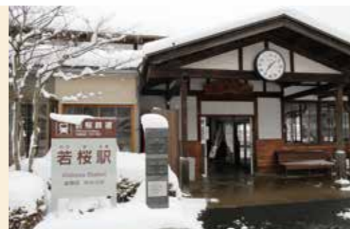
雪に覆われた冬の若桜鉄道・若桜駅。駅舎やホームも登録有形文化財だ
