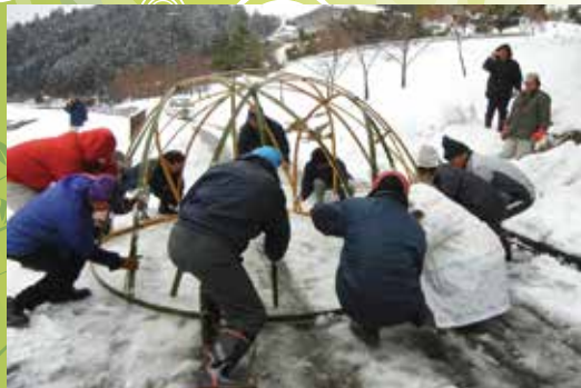
雨のなかスタードームの組み立て作業に取り組む
